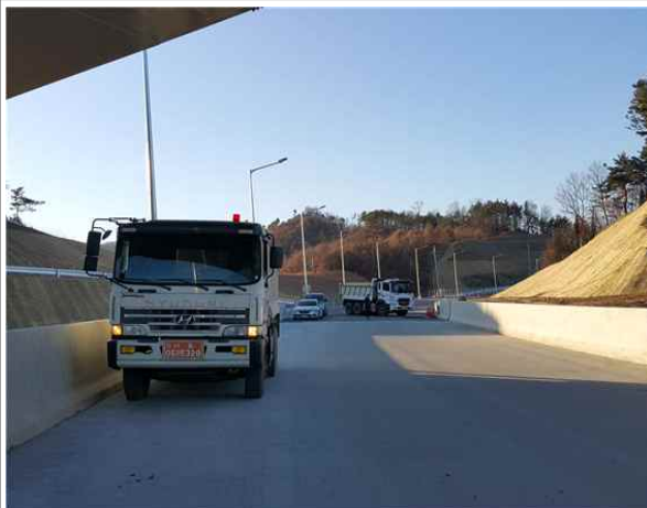
정적 재하시험 전경
